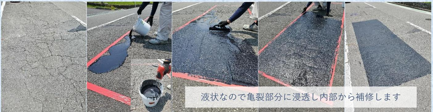
液状なので亀裂部分に浸透し内部から補修します
